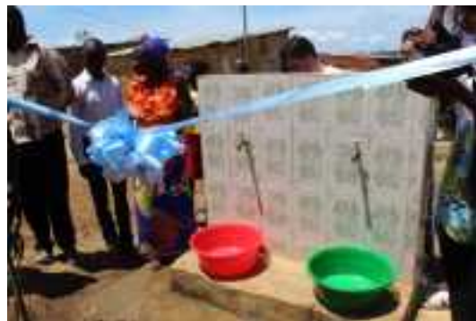
完工した給水場
