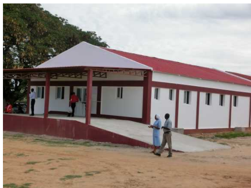
完成した救急病棟
