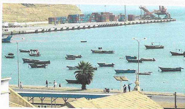
日本の協力により整備が進むナミベ港
